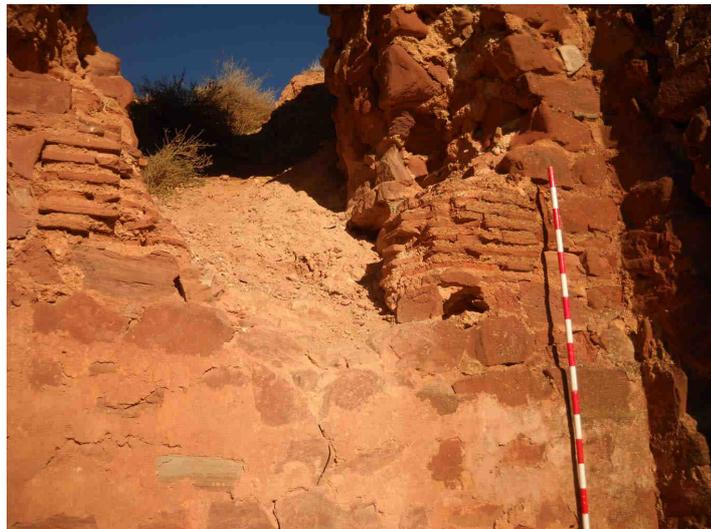
Figura 13.-Vano de la T17 realizado en ladrillo
