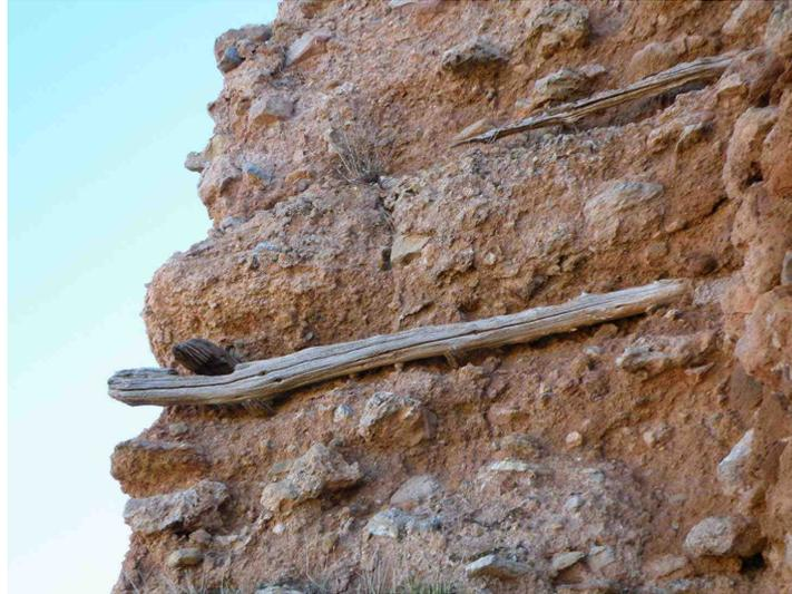
Figura 11.- Detalle sistema refuerzo de los tapiales
